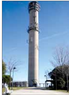
Torre del Agua / F.C.
